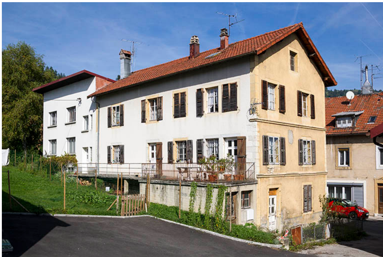
Façades postérieure et latérale gauche.
