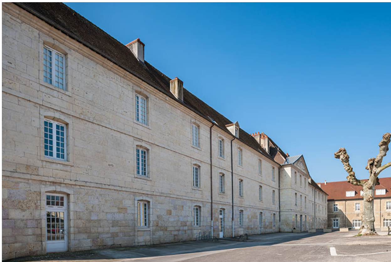
Externat : Vue 3/4 façade antérieure, place Précipiano.
