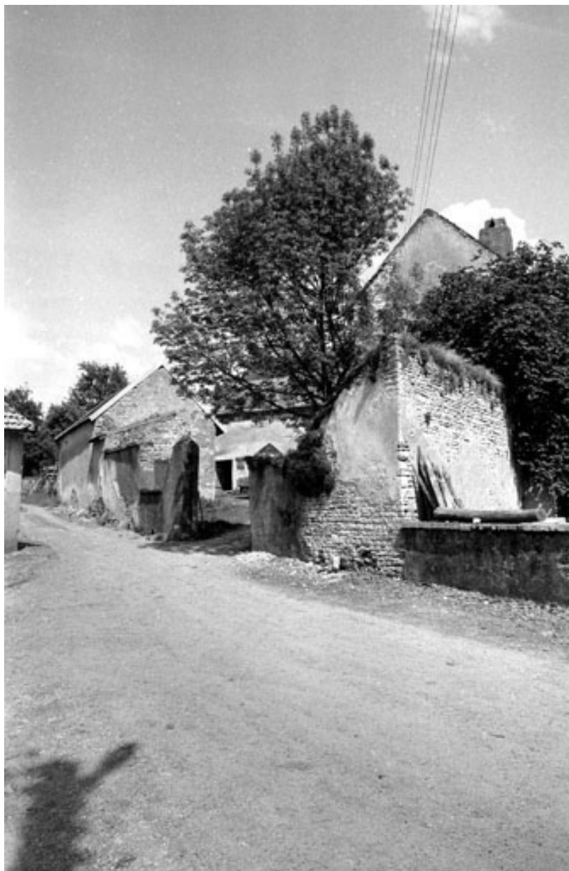
Vue d'ensemble depuis la rue.
