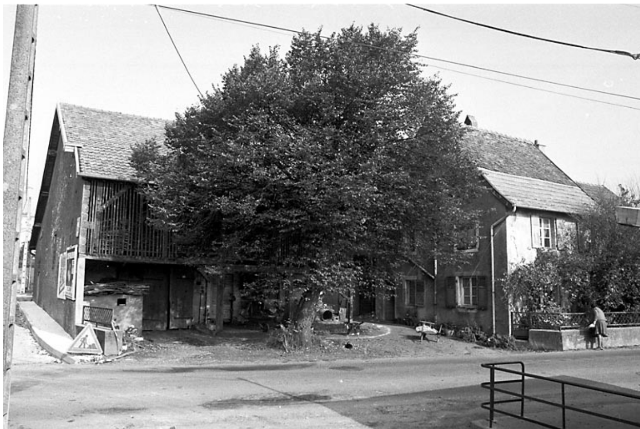
Taillecourt : ferme située Grande Rue.
