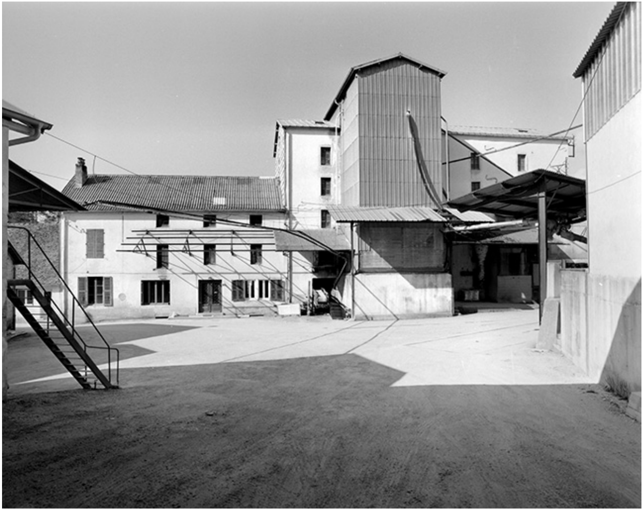
Bureau, atelier de fabrication et silo.
