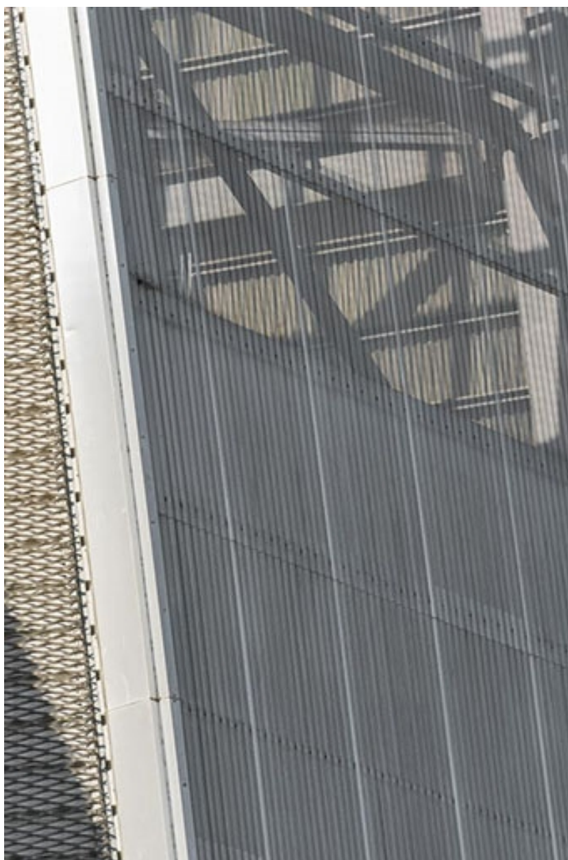
Bardage de la façade-écran.
