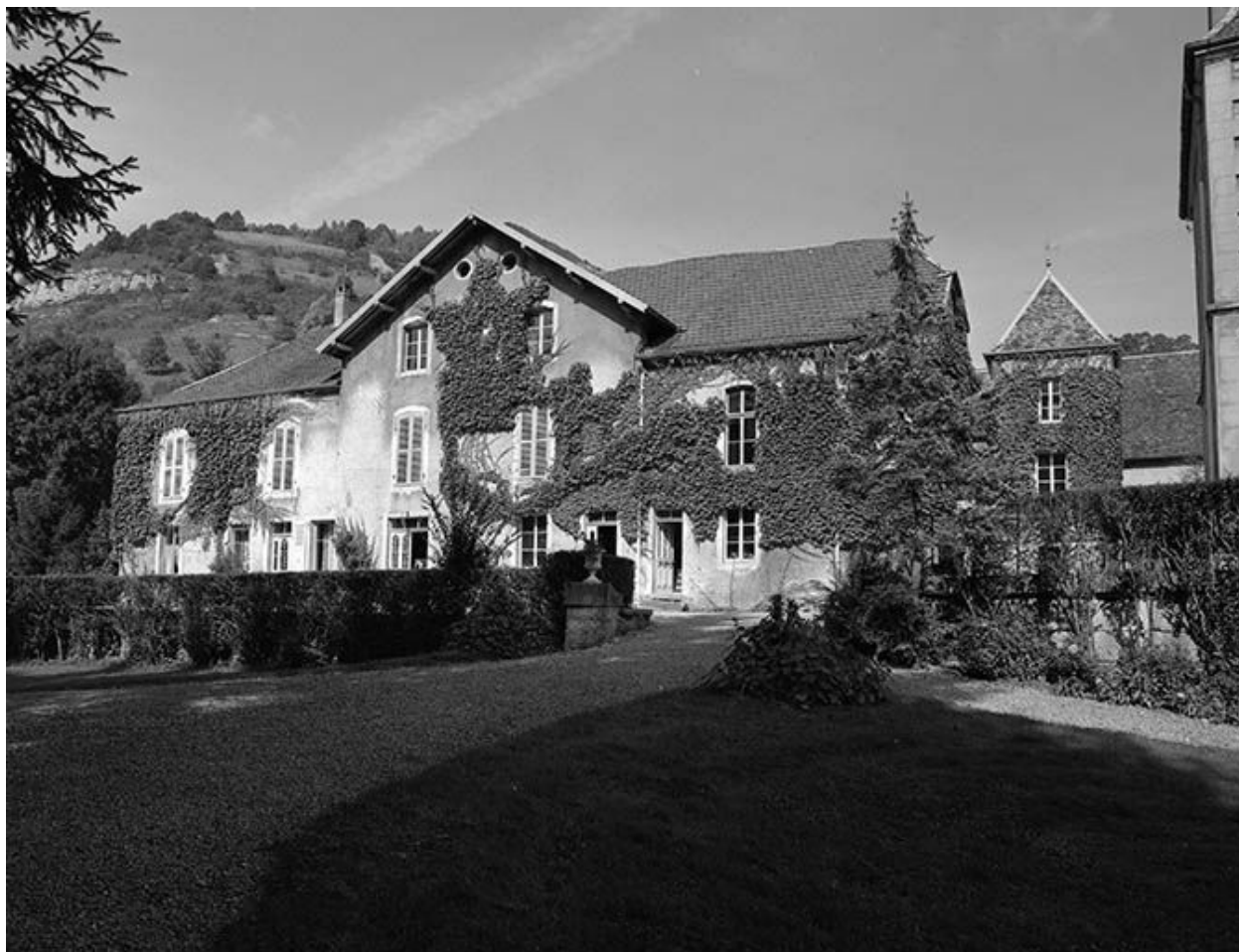
Façade antérieure du logement du gardien.
