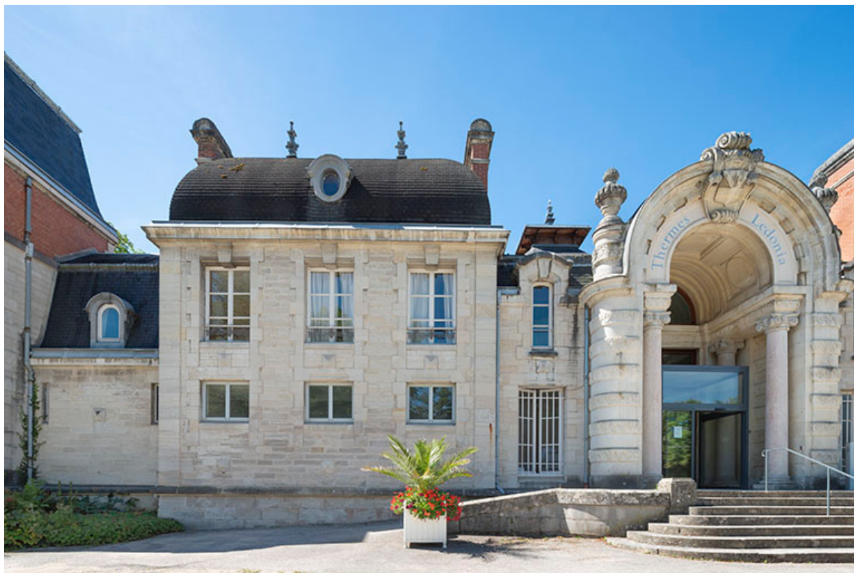
Façade principale, pavillon oriental.
