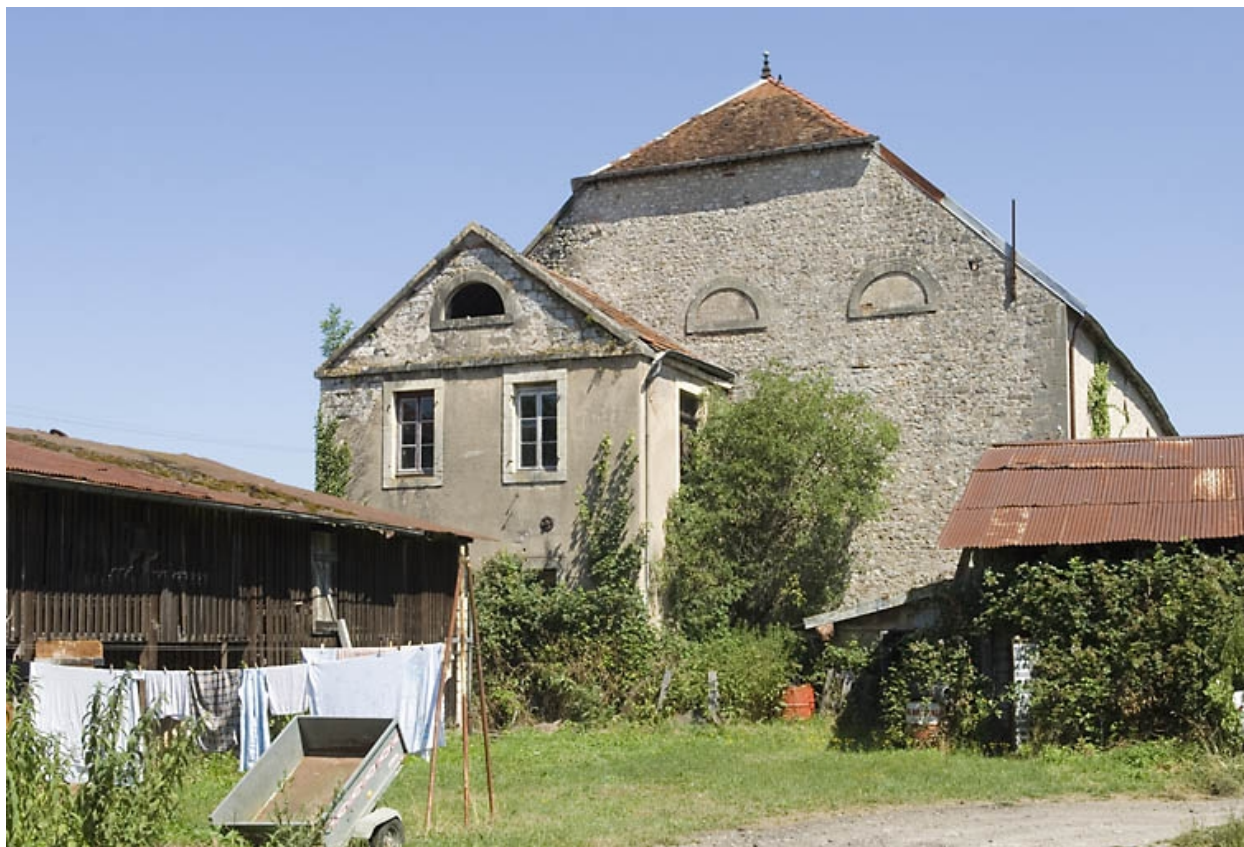
Le haut fourneau vu depuis le sud.
