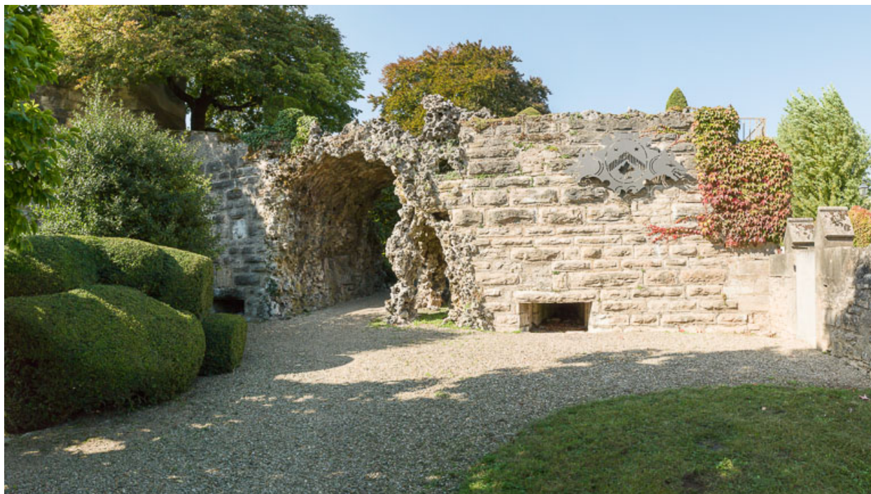
Passage aménagé dans l'ancienne courtine.
