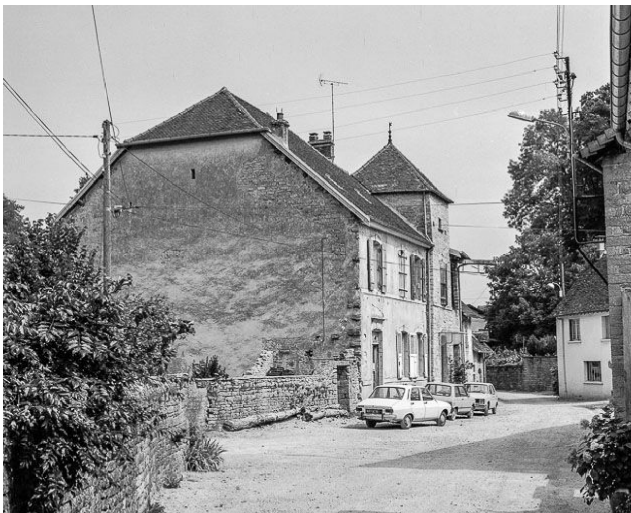
Maison située rue de la Cascade.
