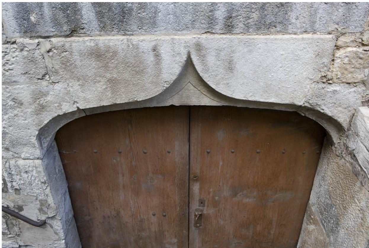
Détail de l'entrée du sous-sol sur cour.
