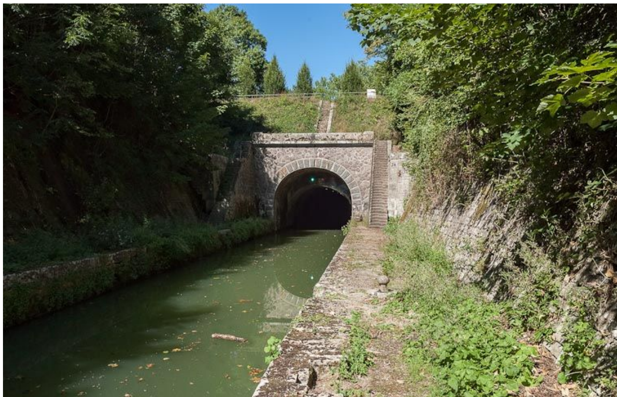
Vue de l'entrée du tunnel à Créancey.
