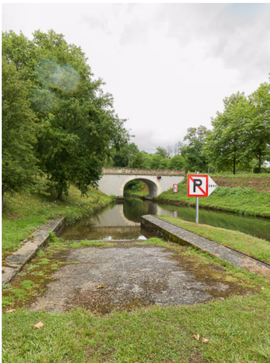
Vue d'ensemble du pont.
