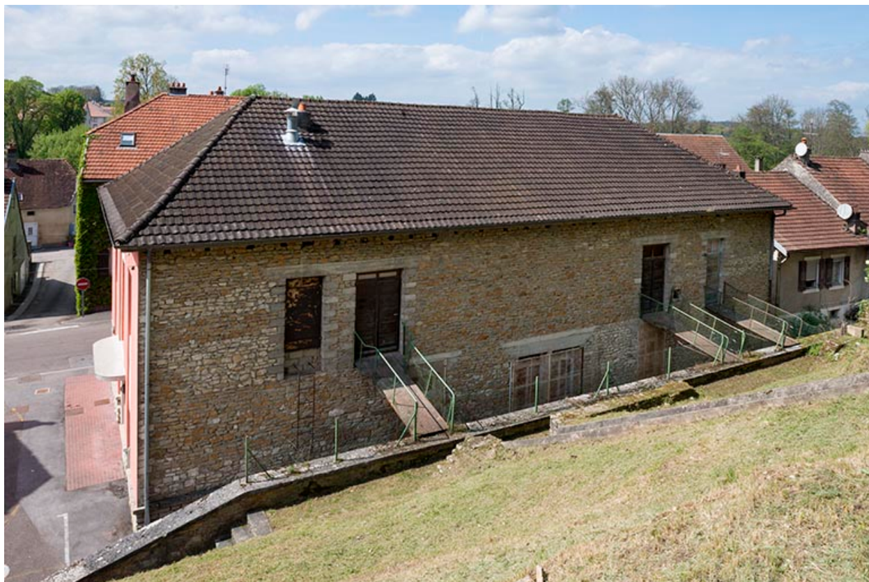
La façade postérieure.
