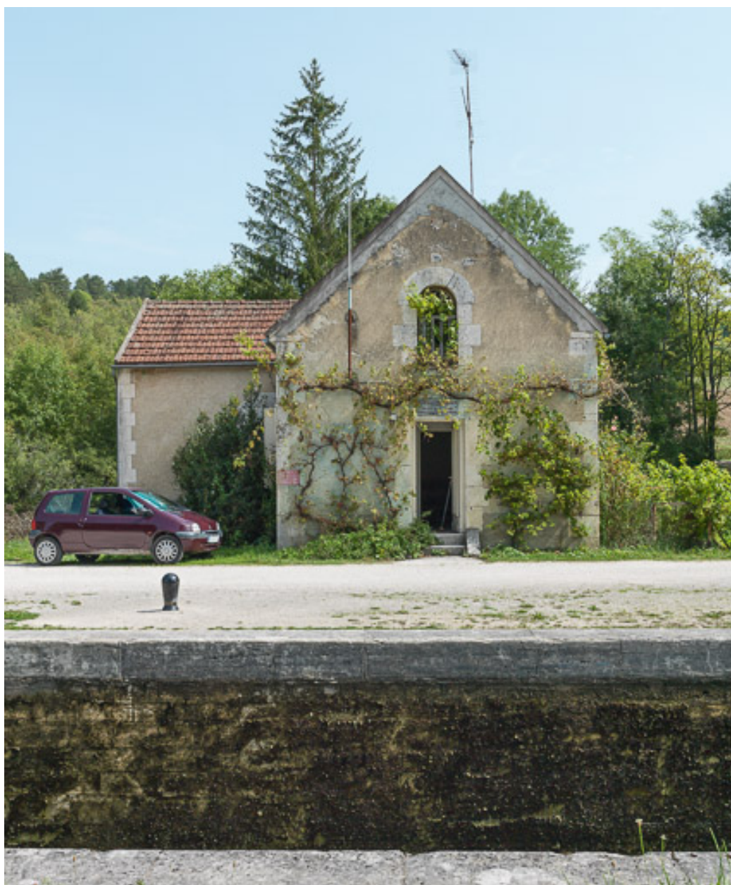
Vue de la maison éclusière.
