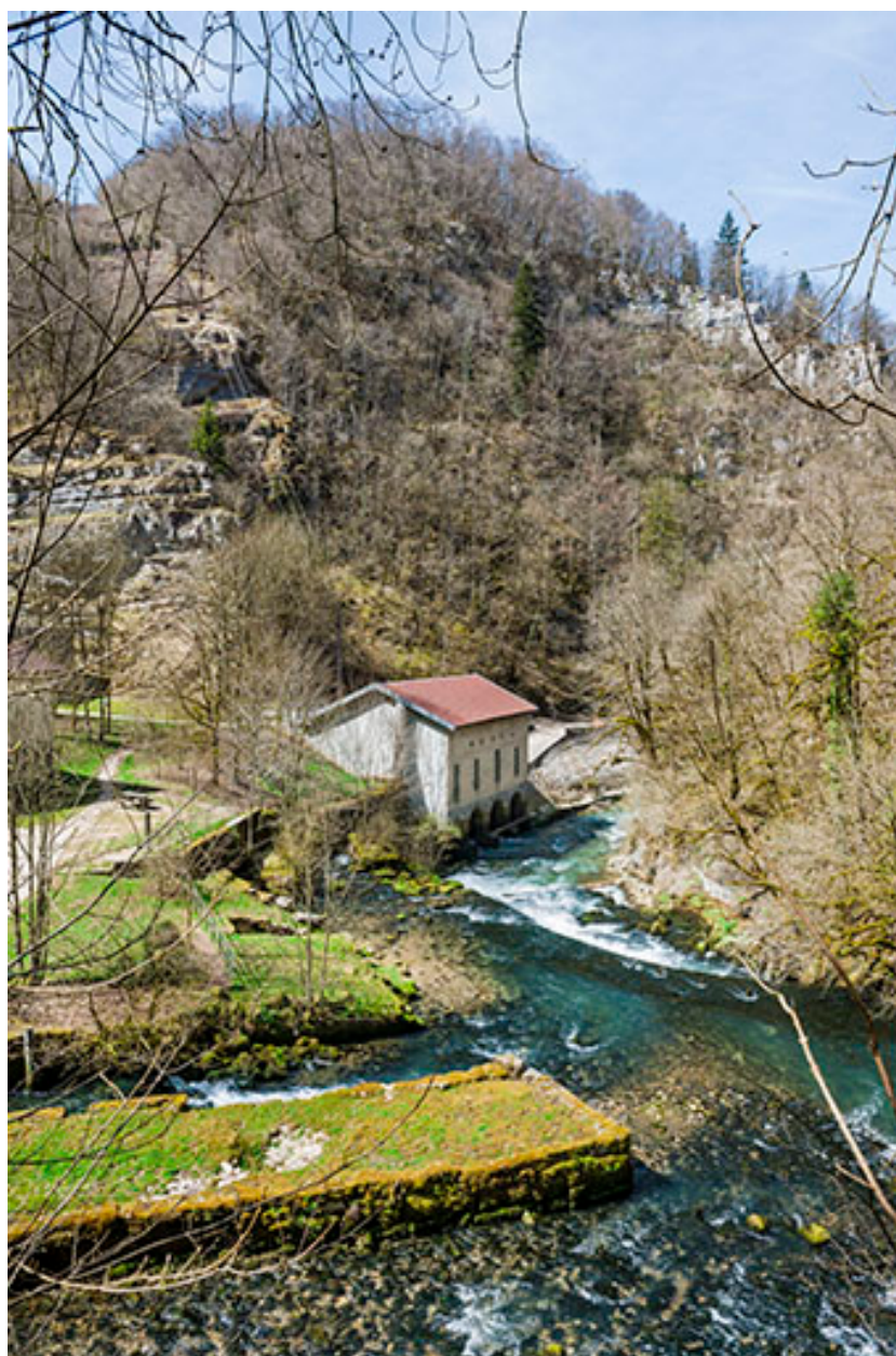
Vue plongeante sur la centrale.
