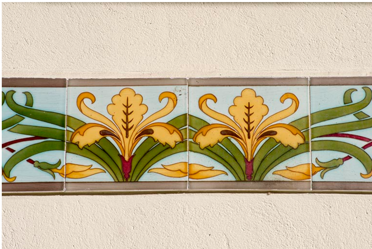
Pignon est de l'atelier. Détail des faïences.
