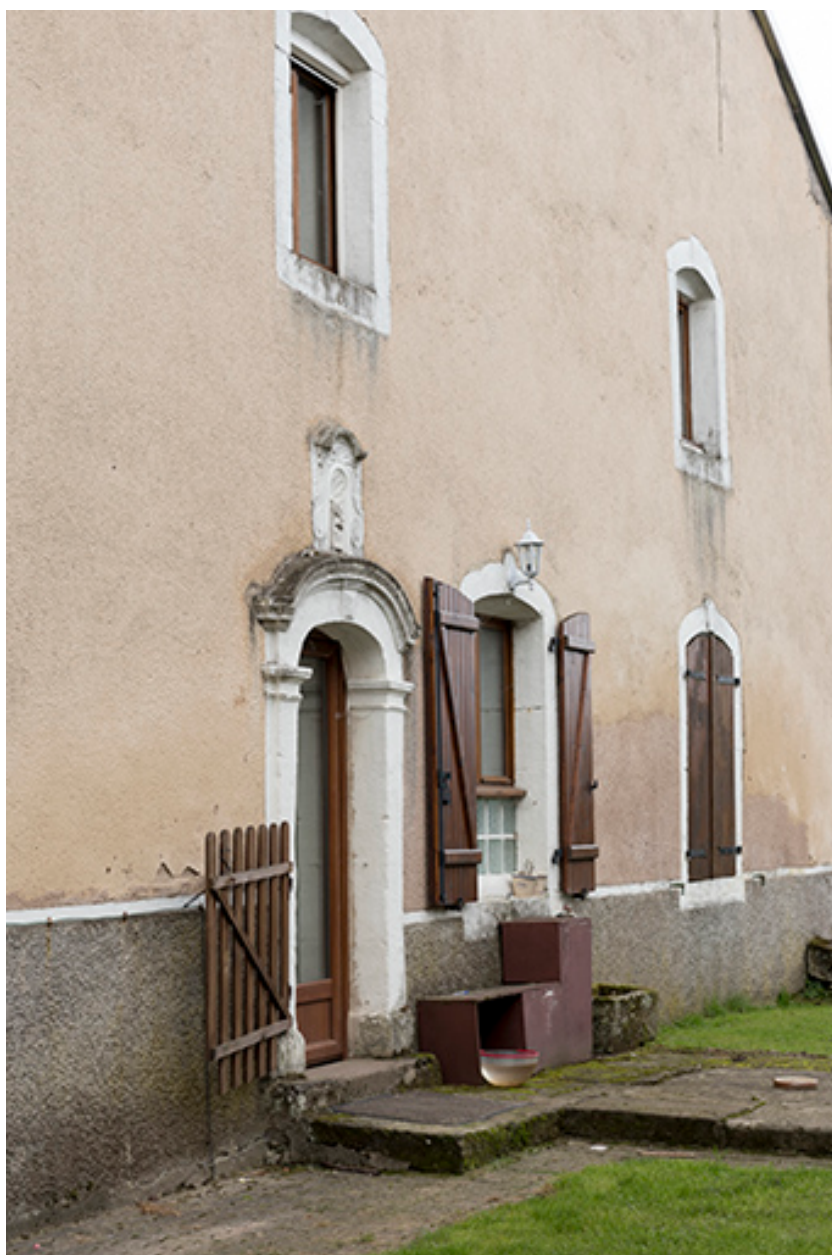
Détail de la façade antérieure.
