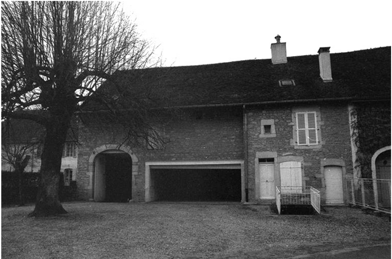
Maison de vigneron : façade antérieure.
