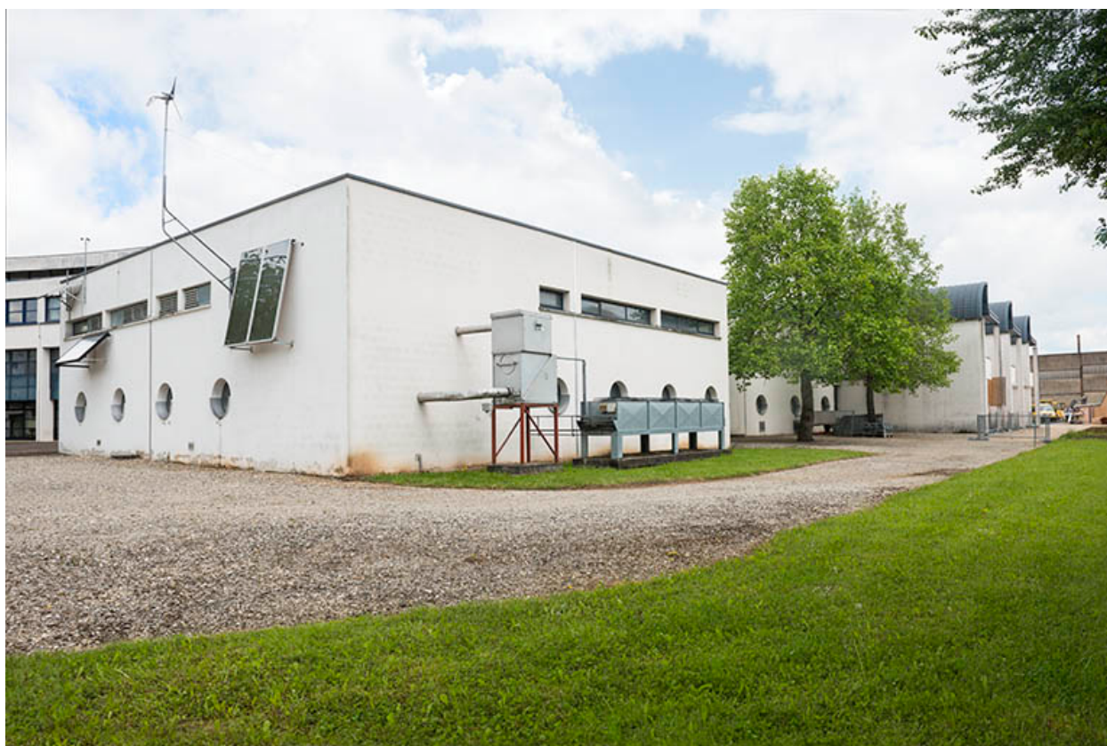
Angle sud de l'extension sud-ouest de l'atelier.
