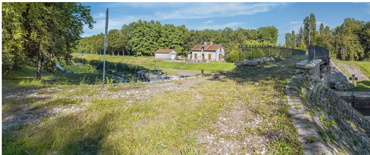
Site de l'écluse 20 dite d'Auxonne avec sa maison éclusière au centre (21).
