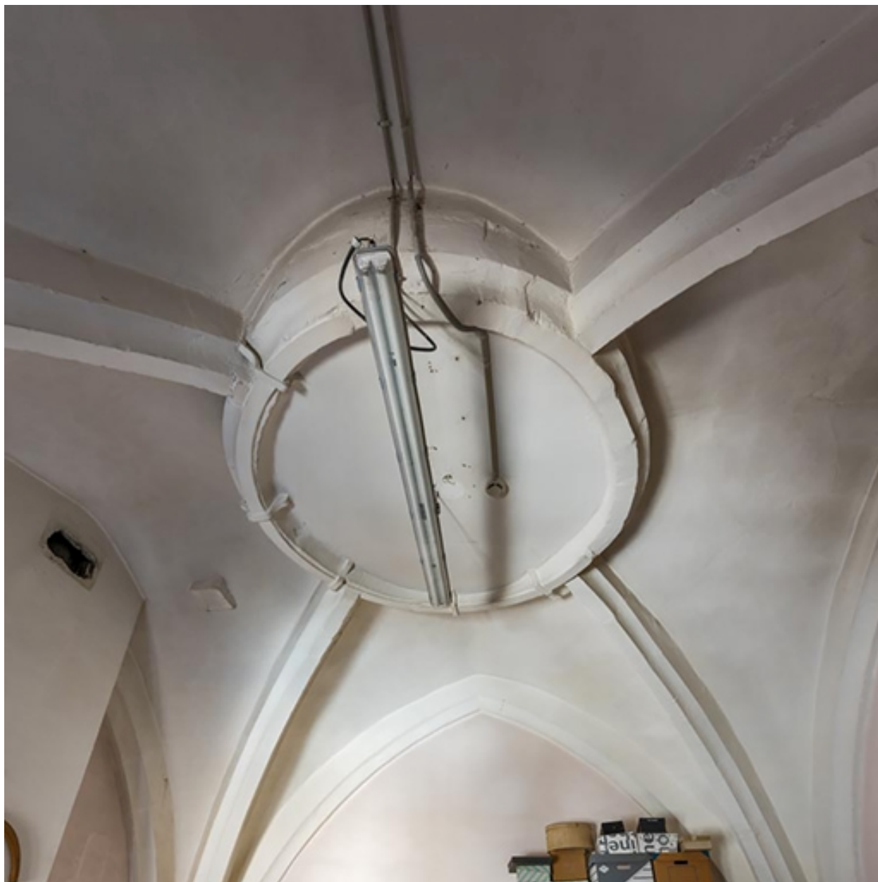
Tour nord, premier étage : voûte d'arêtes avec ouverture zénithale (bouchée).
