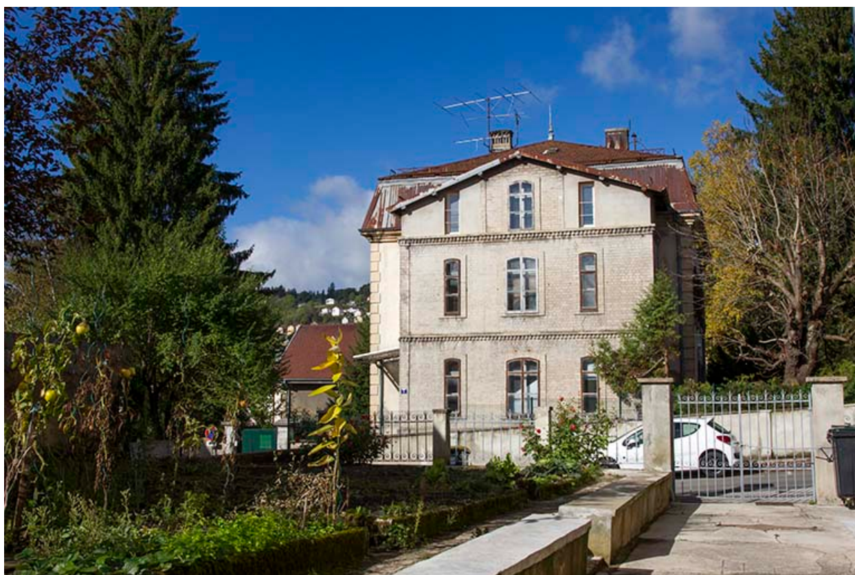
Logement patronal, vu de l'est.
