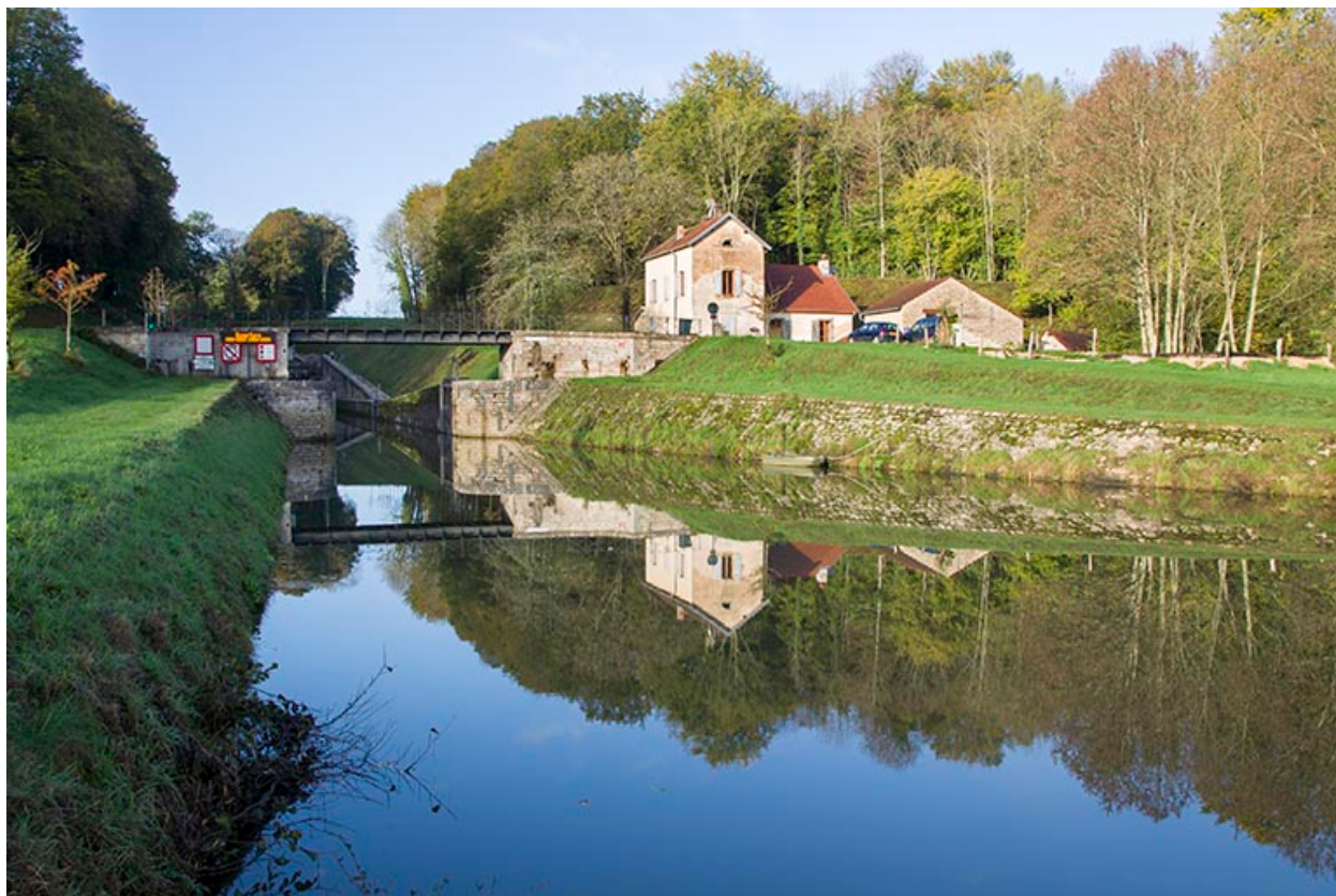
Entrée du canal depuis l'amont.
