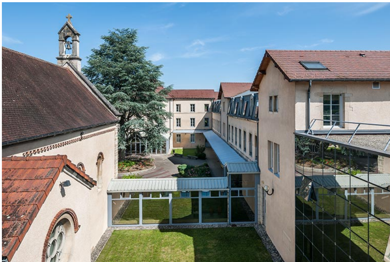
Façades Est sur cour : externat, chapelle.
