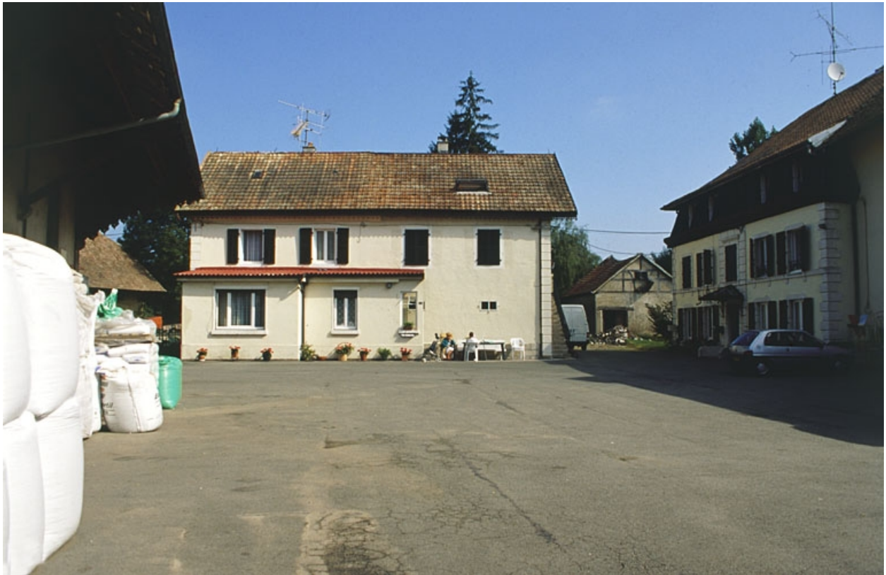
Logements depuis la cour.
