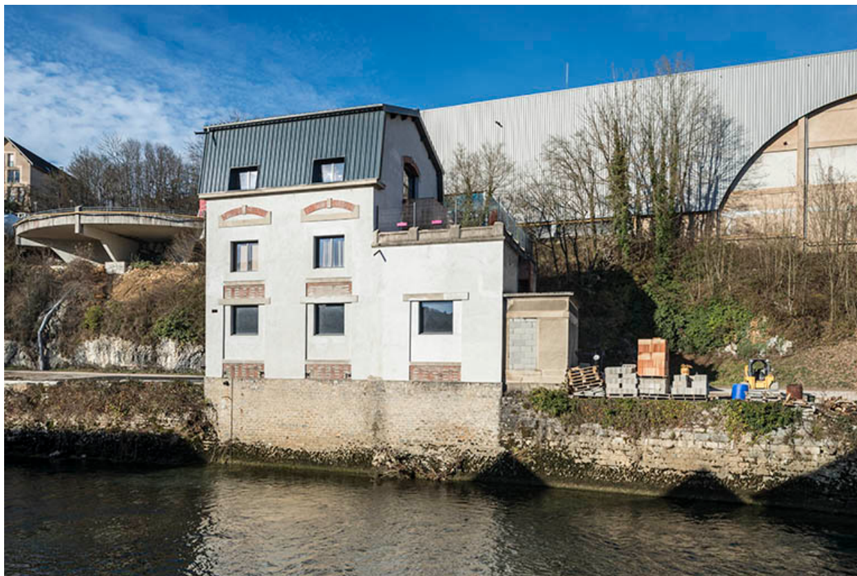
Transformateur. Façade sud.
