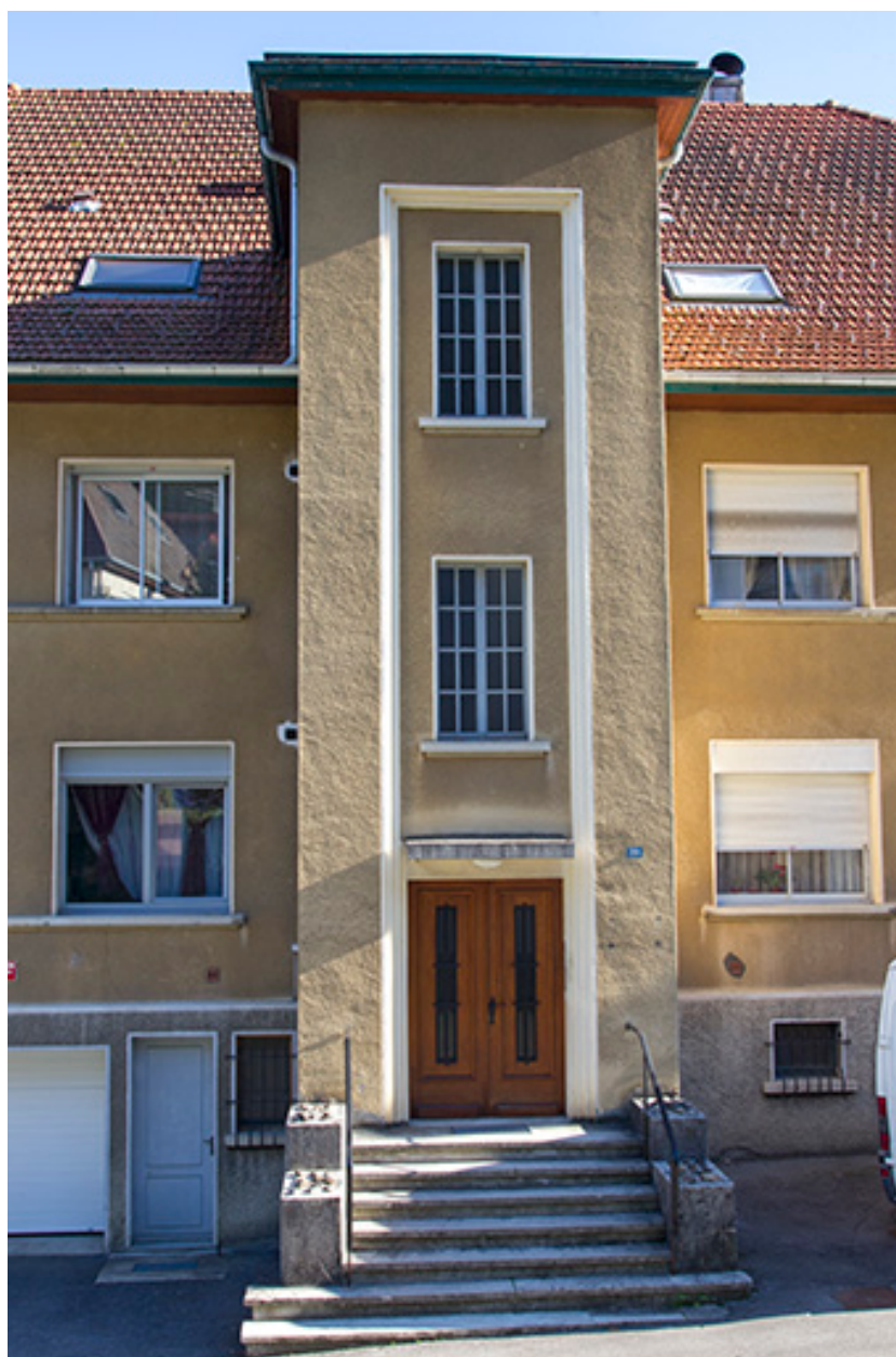
Entrée et cage d'escalier.
