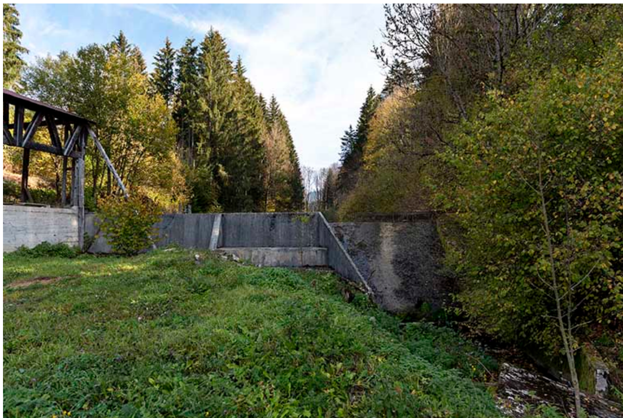
Bassin de retenue.
