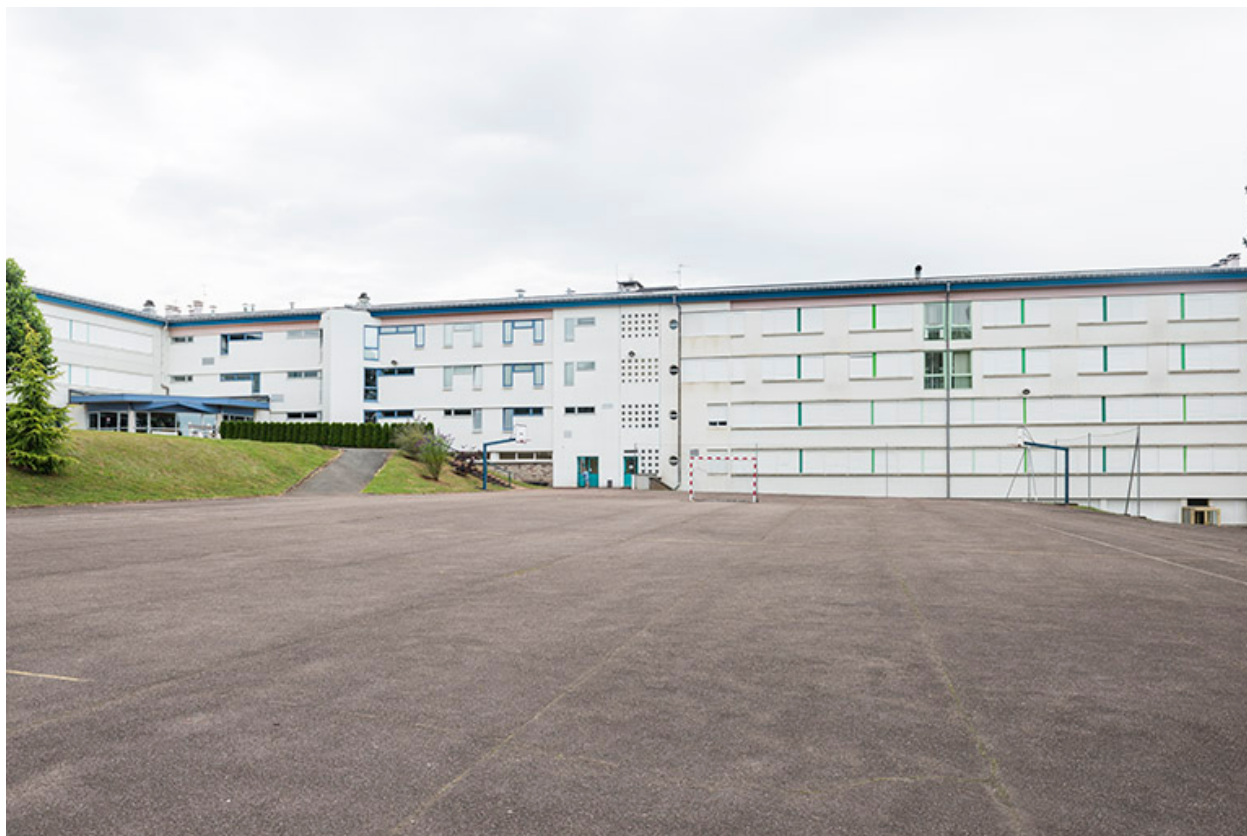
Externat et ateliers : vue générale
