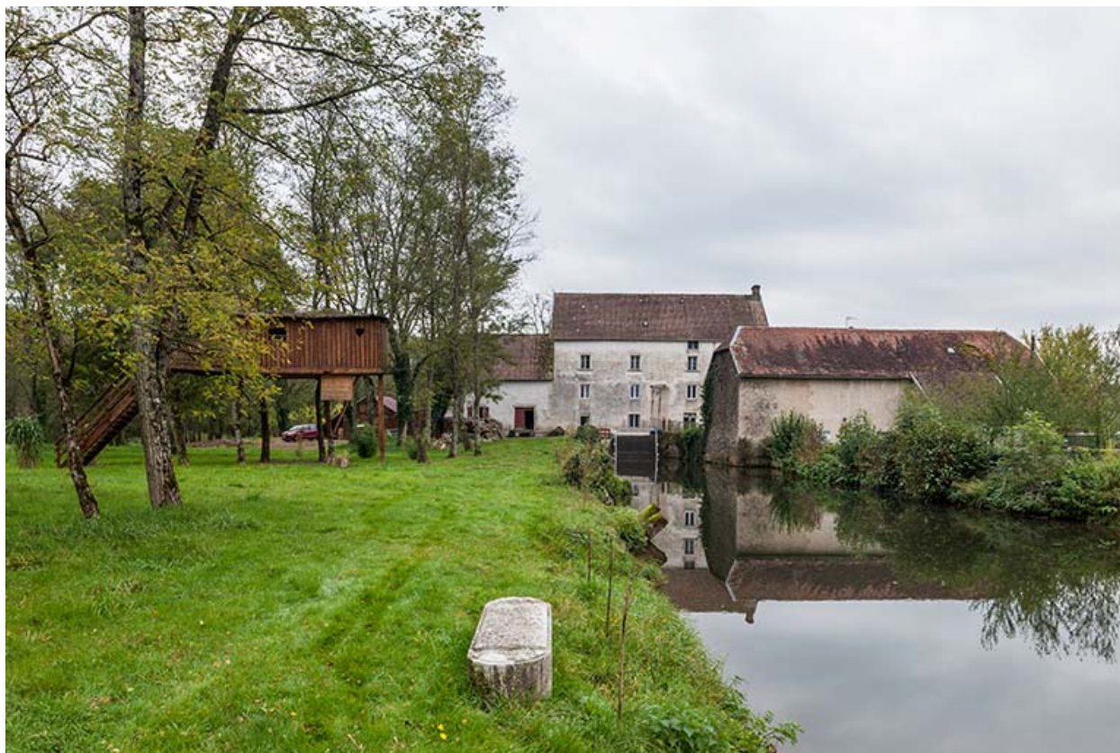
Vue d'ensemble depuis le bief d'amenée.
