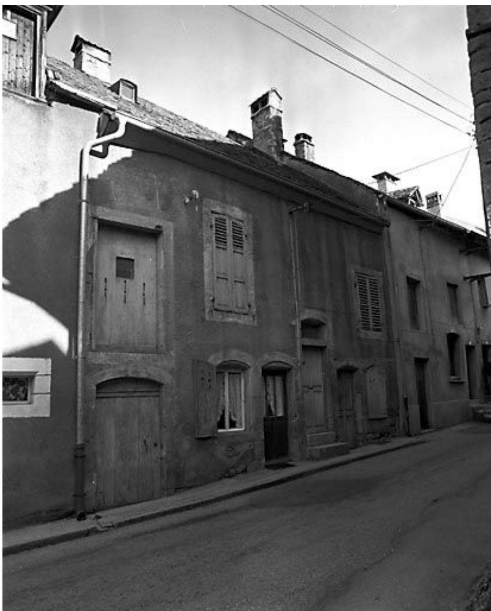
Maison de vigneron située 14 rue du Champliman.
