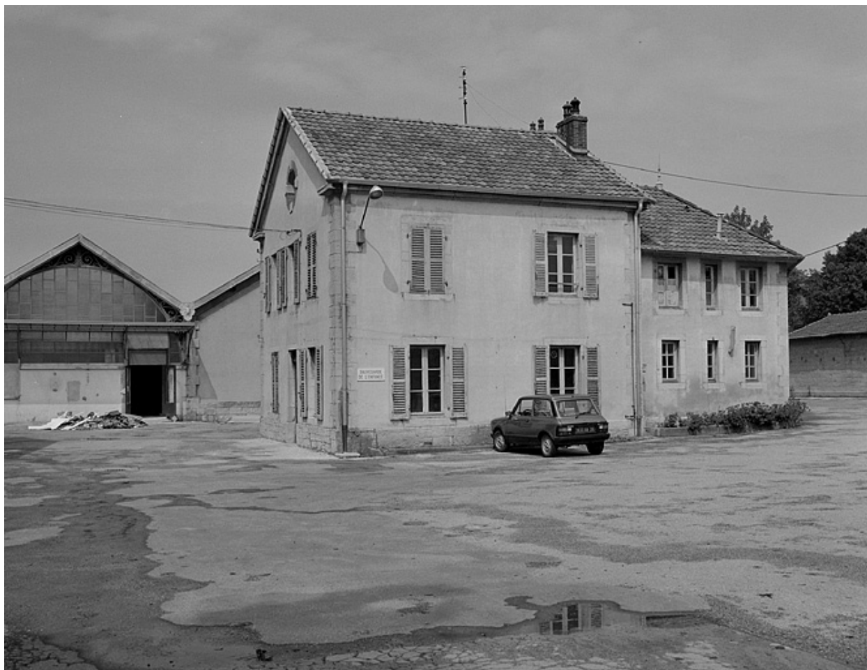
Pavillon d'entrée droit.
