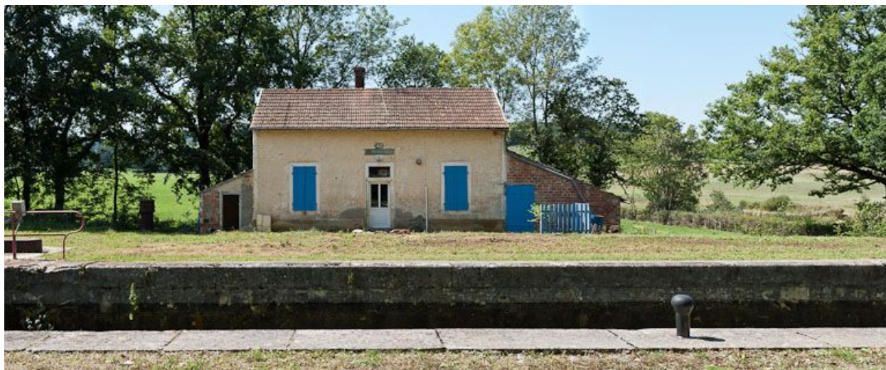
Vue de face de la maison éclusière.
