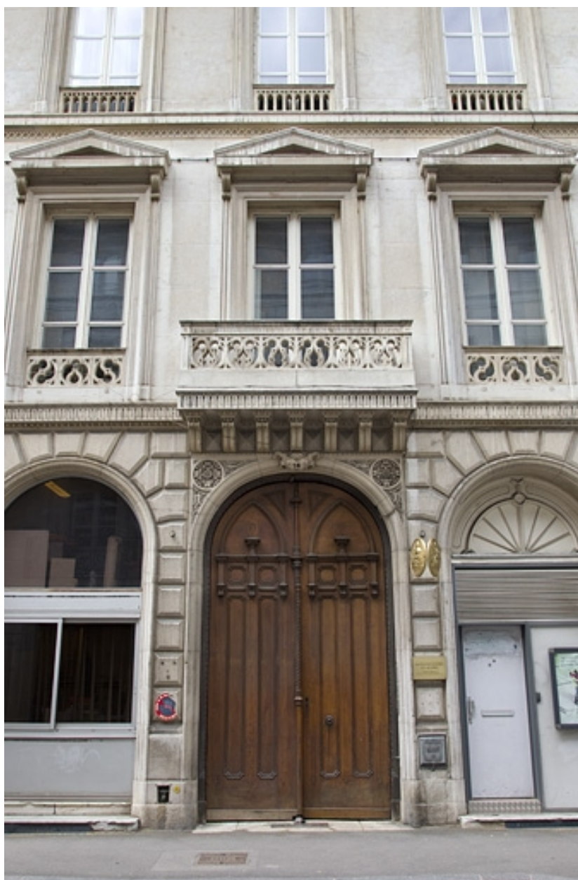
Vue d'ensemble du portail d'entrée.
