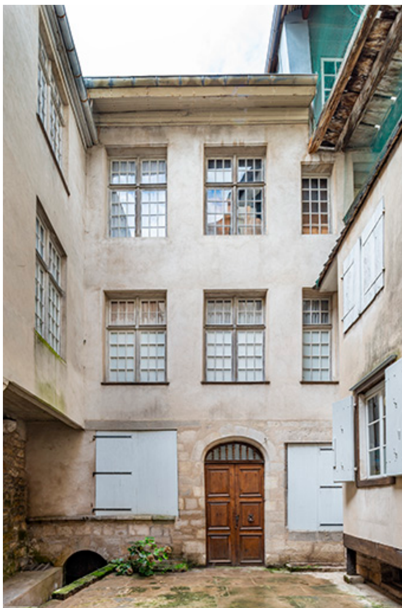
Façade est du logis sur cour.
