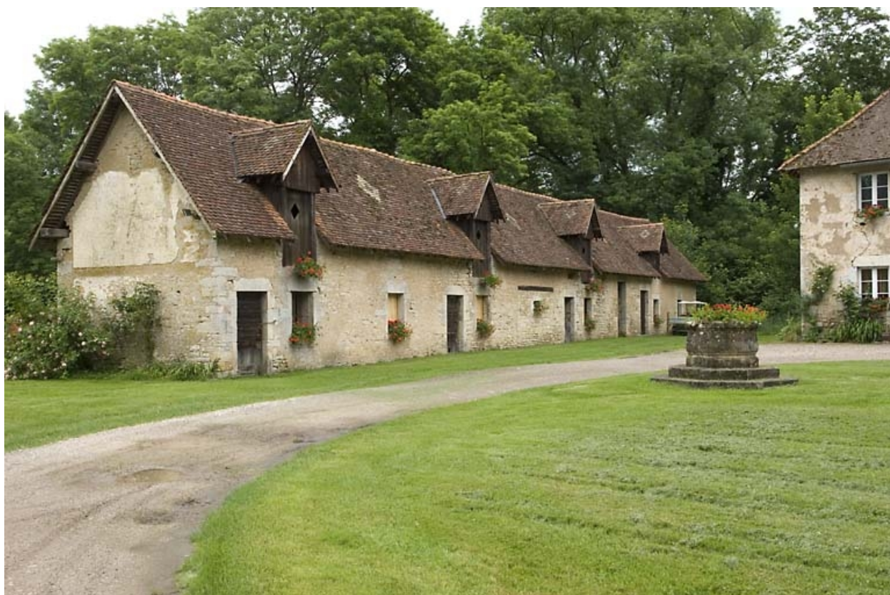
Logement ouvrier vu depuis le nord.
