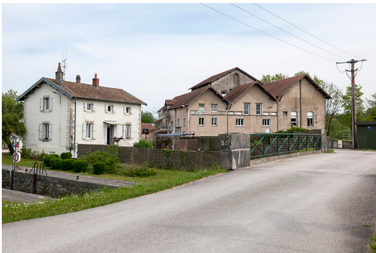
Vue d'ensemble depuis l'entrée.
