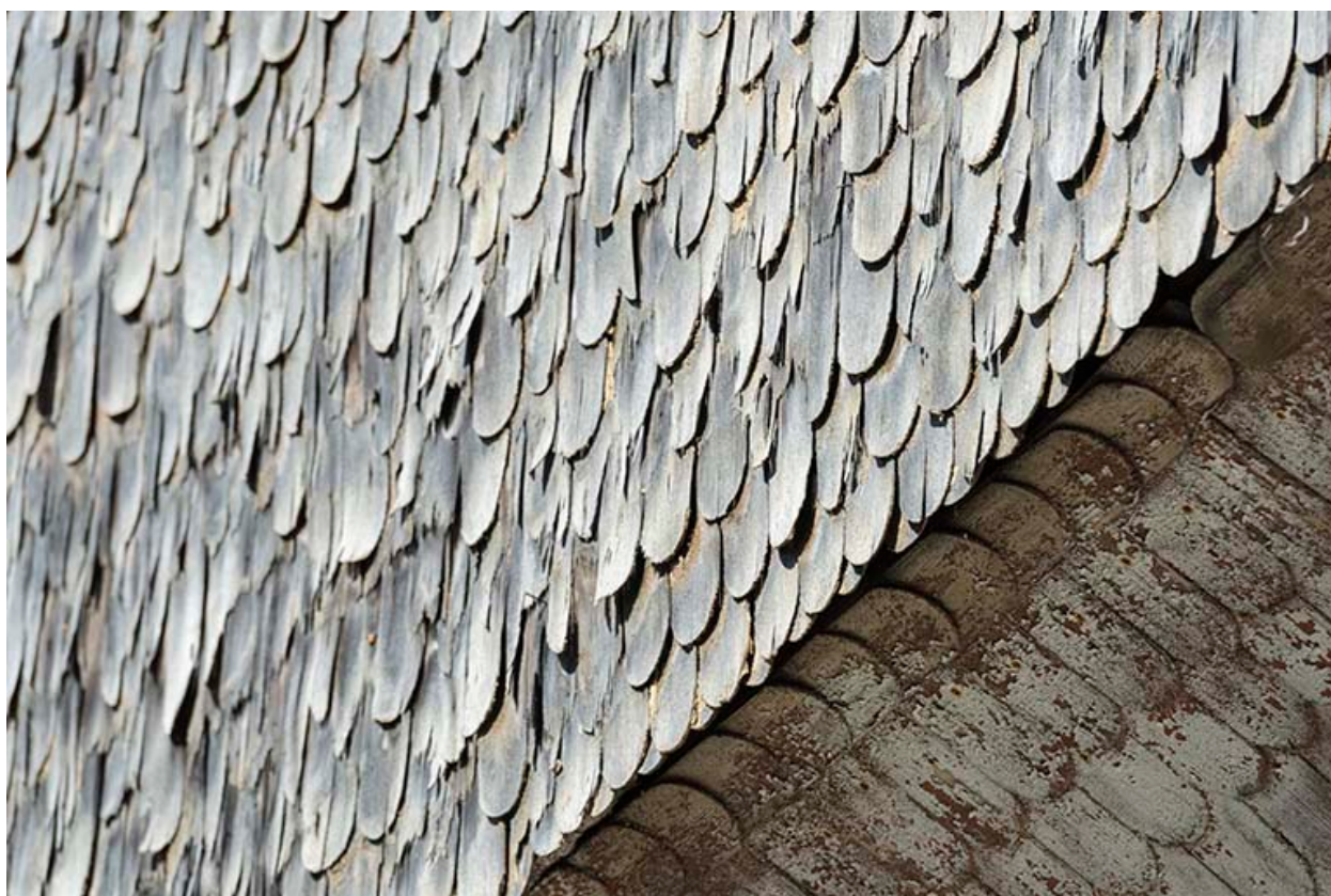
Façade postérieure : essentage de tavillons.
