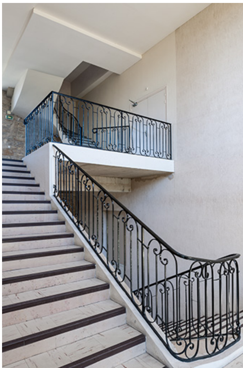
Internat, escalier intérieur.
