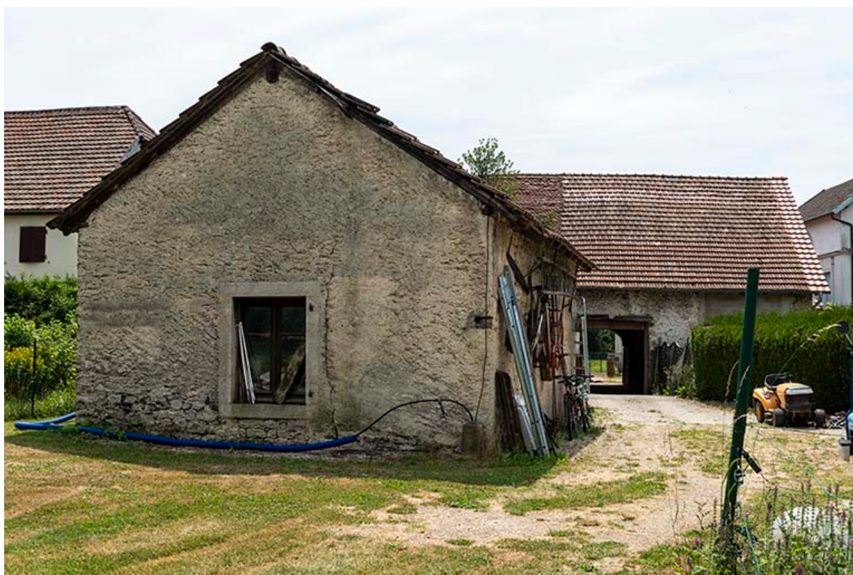
Forge : façade postérieure, de trois quarts droite.
