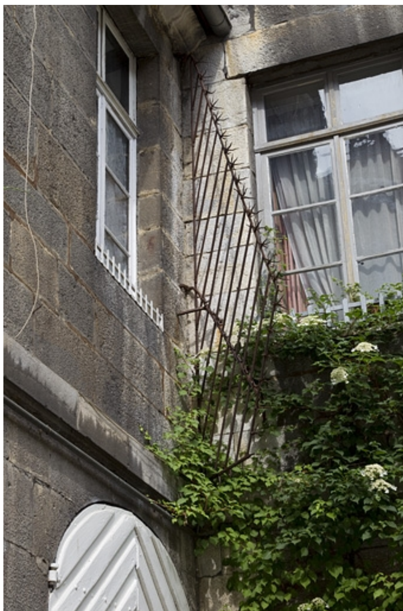
Cour : détail d'une grille de protection.
