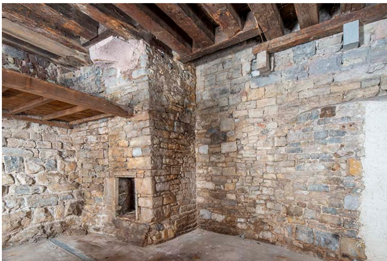
Cave ouest. Maçonneries à l'angle nord-est.
