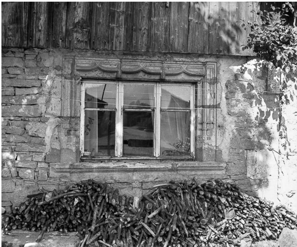
Façade antérieure : fenêtre.
