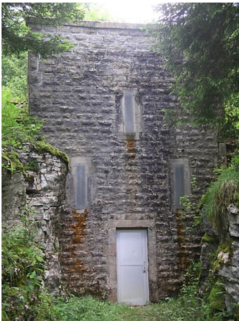
Vue générale sur construction hydraulique.
