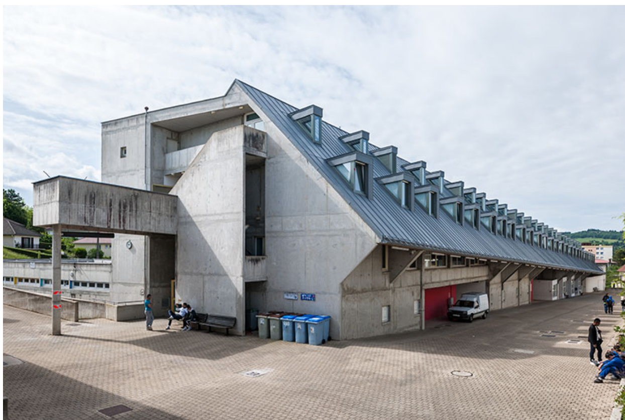
Façades et pignon nord du bâtiment internat-administration.
