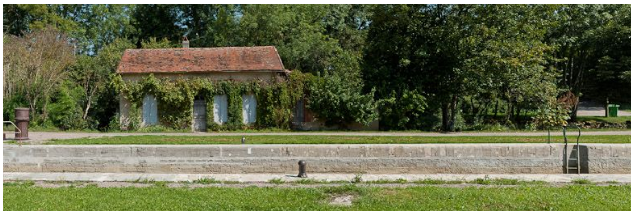
Vue de face de la maison éclusière.
