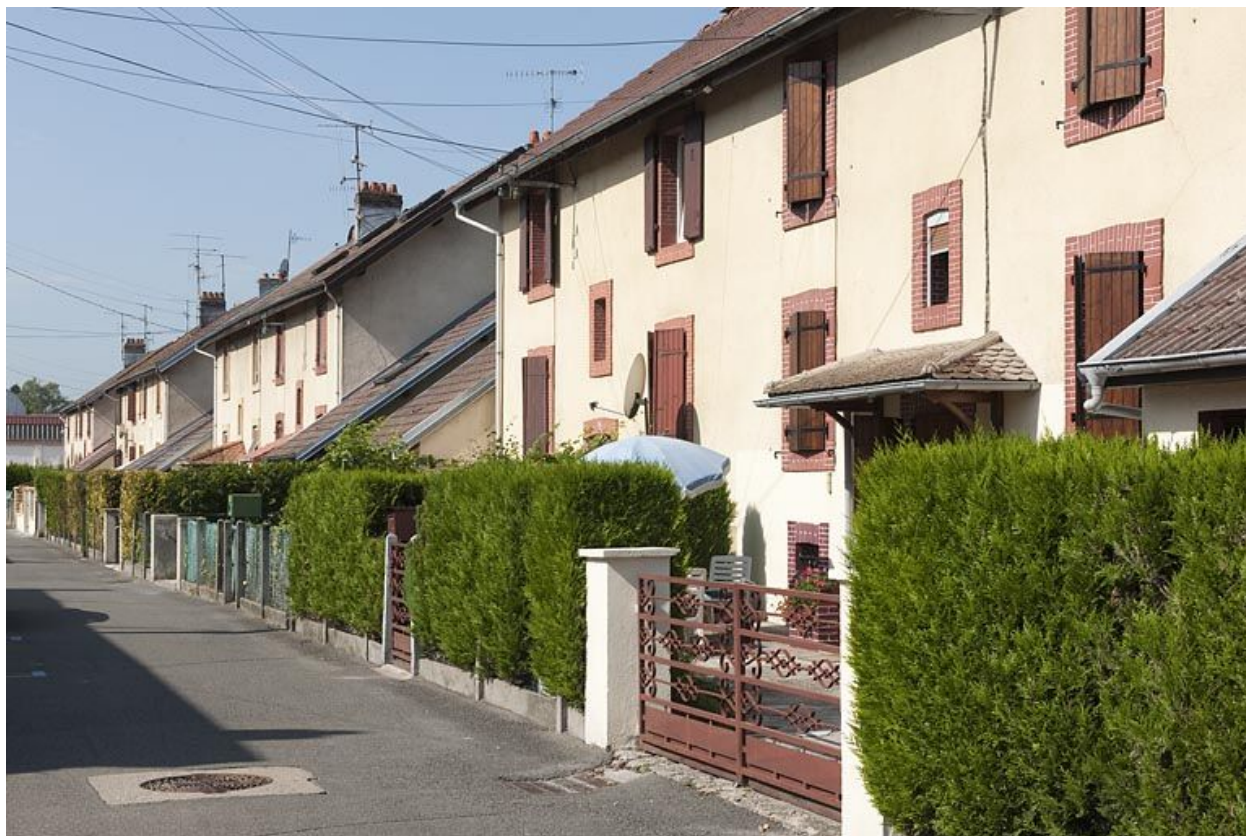
Rue de la Marne. Façades est.
