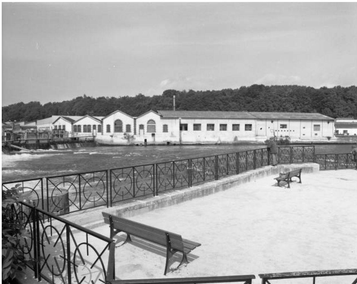
Bâtiments sud depuis la rive droite.
